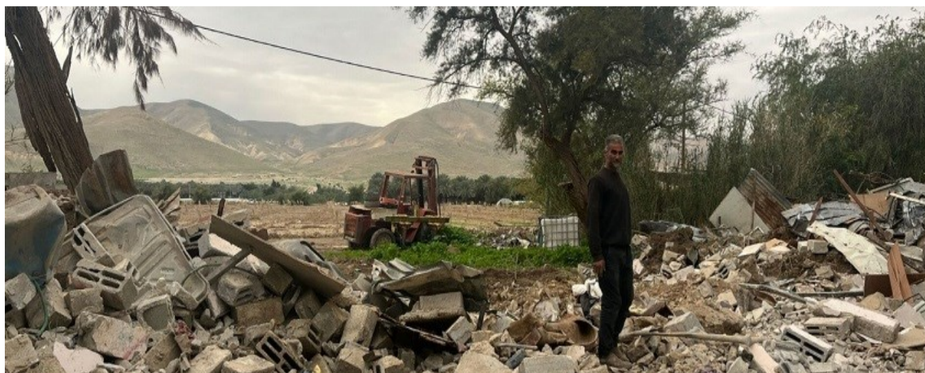
Imagen de una demolición de vivienda (fotografía de OCHA)
