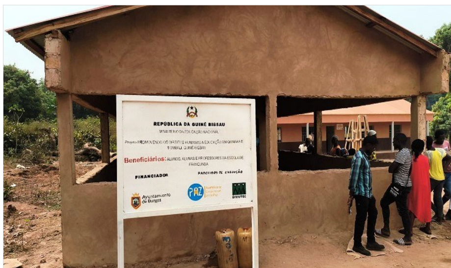
Vista de comedor escolar de Francunda. Foto DIVUTEC, 2026
